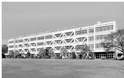
平成21年度に耐震補強工事を実施した校舎
